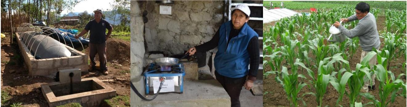
**Biodigestor Tubular de geomembrana, Modelo familiar, de flujo continuo de 10 m<sup>3</sup> de capacidad (80% base líquida y 20% biogás) para el tratamiento de excretas vacuno, porcino, caprino, cuyes y otros animales. Requerimiento mínimo de 3 cabezas de ganado vacuno o 10 cerdos.**
